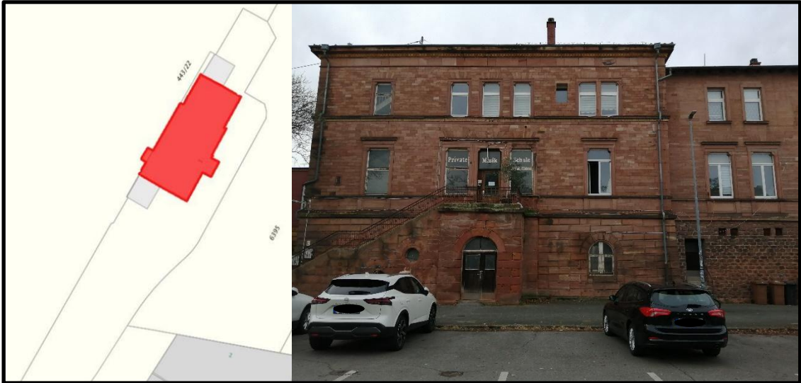
Lage des Kulturdenkmals (links) und Fotoaufnahme der Westfassade (rechts)
